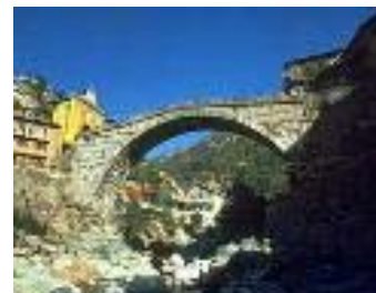
Il ponte di San Martino
